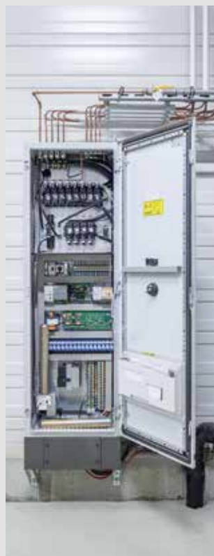
Pneumatik-Schaltschrank – Hier läuft die Steuerung der gesamten Anlage zusammen.
