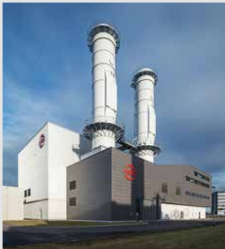
Zwei moderne und höchst effiziente Spitzenlast-Gasturbinen sorgen für eine Leistung von rund 100 MW.
