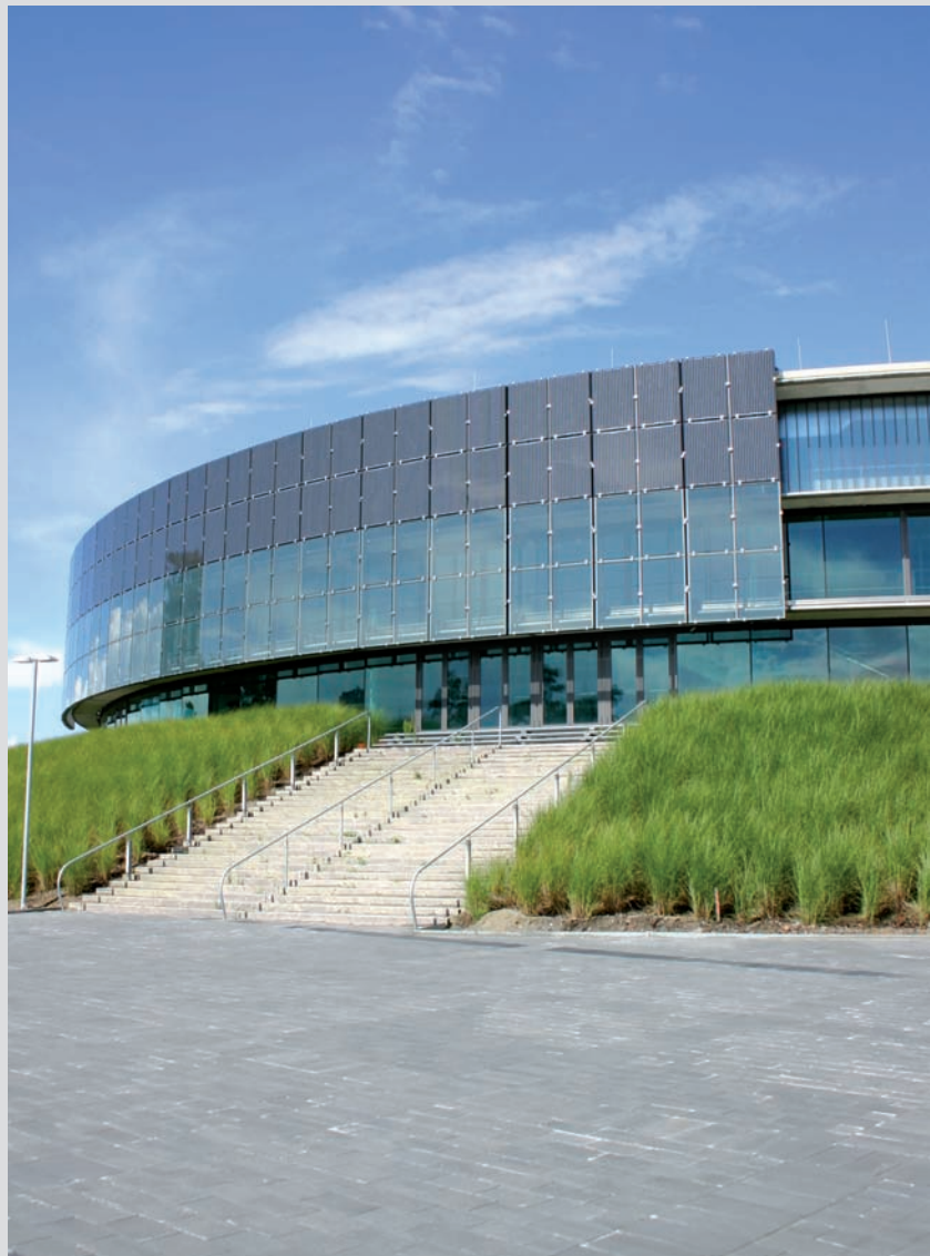
▲ Die Module wandern mit der Sonne die Fassade entlang und werden so optimal als Energiequelle und Sonnenschutz ausgenutzt
