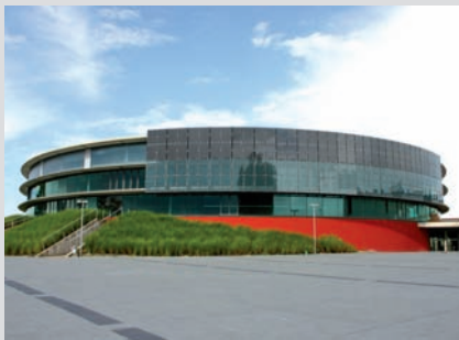
▲ Scheinbar schwebend folgt der Wandschirm mit den Photovoltaikmodulen dem Sonnenstand
