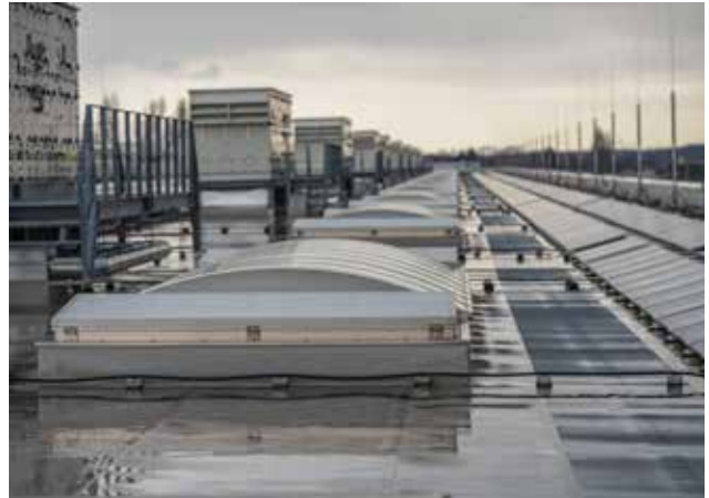
Zum Einsatz kommen durften nur nach EN 12101-2 geprüfte und zugelassene Rauchabzüge, wie die Apollo Haubenlüfter.
