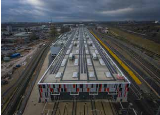
500 Meter lange Werkshalle mit Brandschutz ausgestattet
