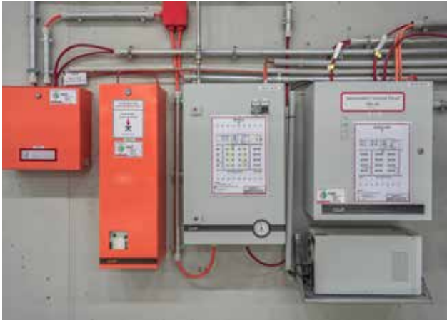
Pneumatische Schaltkästen für die Ansteuerung von natürlichen Lüftungs- und Brandlüftungssystemen
