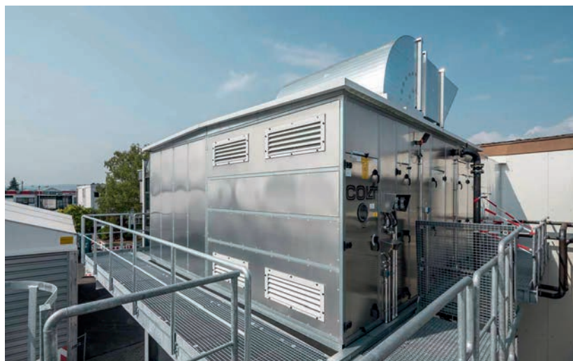
Kompaktes mechanisches Lüftungssystem für die Luftzuführung und Klimatisierung.
