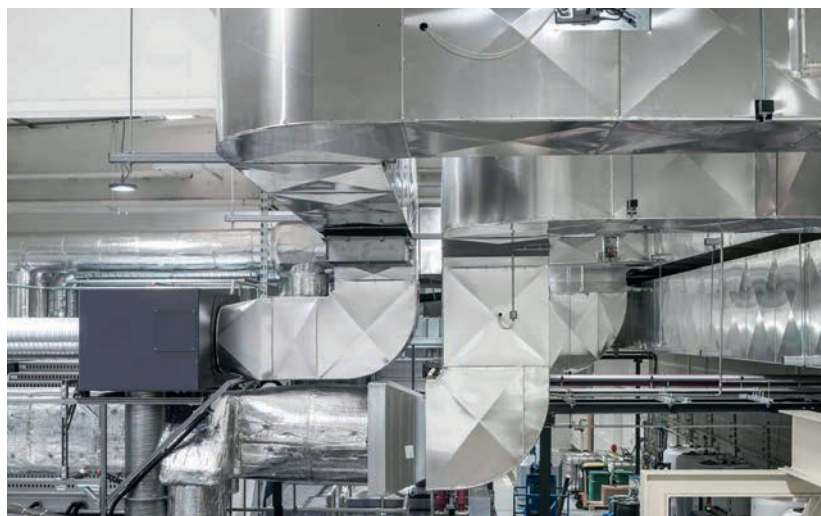
Colt hat sowohl die Zuluft als auch die Abluft für die Versorgung der Trockner bereitgestellt.
