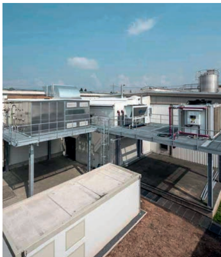
Maschinenkühlung mit einem adiabatischen Rückkühler.
