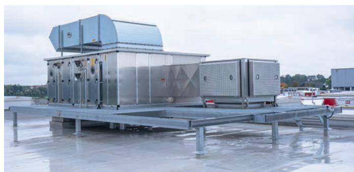
Auf dem Dach wurde eine Colt-„Tristar“-Anlage installiert.
