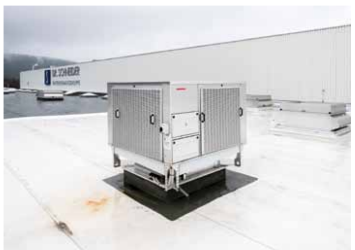
Der „CoolStream“ arbeitet dabei mit Verdunstungskühle.
